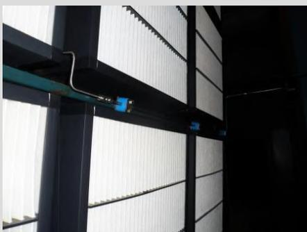
Z-Line<sup>GT</sup> im Einsatz in einem Filterhaus in England. Als Version mit Kopfstützrahmen konnte die Vorfilterzelle problemlos in das bestehende Rahmensystem integriert werden. Unmittelbar nachfolgend eingesetzt sind EMW® Minipleat – Kompaktkassetten F8 des Typs [MPK 48 – 20 GT](#)
